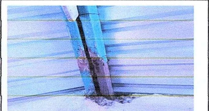
Foto 2: Las cubiertas de la costanera ya no estan en buenas condiciones Pde la escuela ya no estan completas se añade con un pedazo de madera
